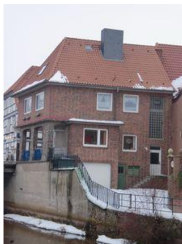
■ Südansicht, Blick vom Wall
