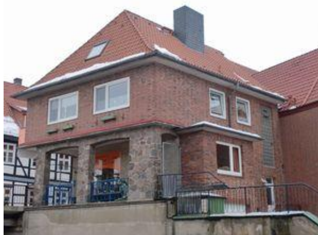
■ Ostansicht mit Freifläche
